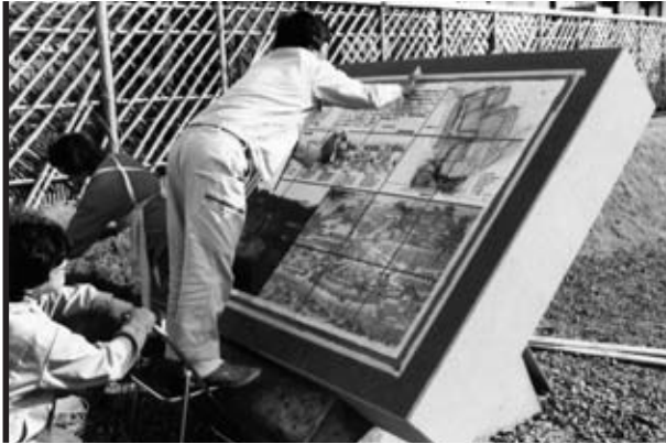
3 説明板工 磁器板貼り付け状況
