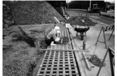
4 レンガ舗装 施工状況
