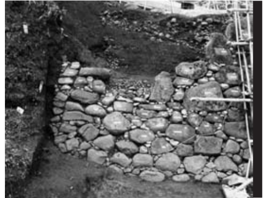
4 石垣①解体完了（南から）
