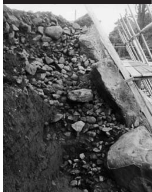
2 石垣①背面 裏栗状況（南西から）
