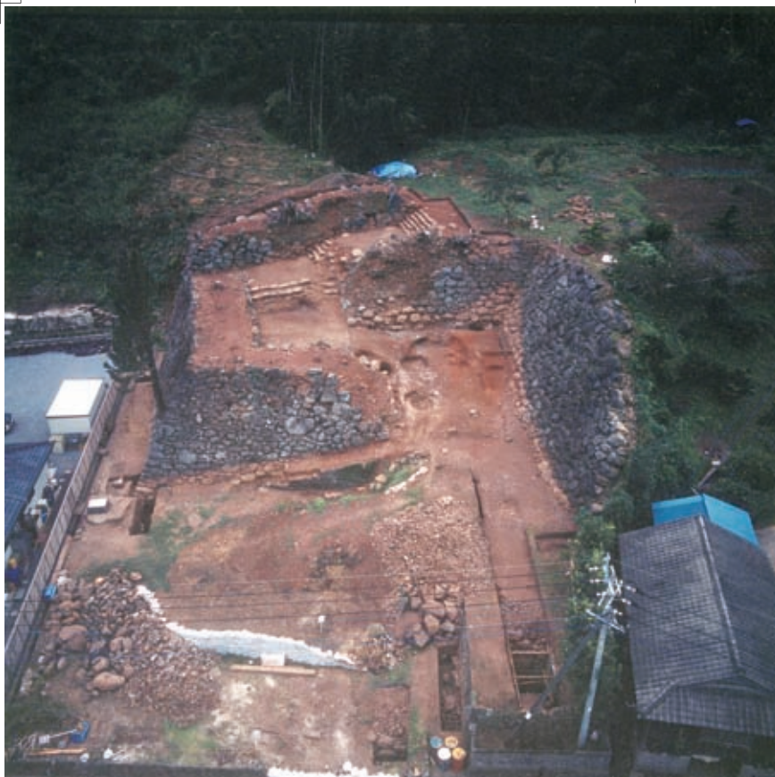
1 名護屋城跡山里口発掘調査状況（北東から）
