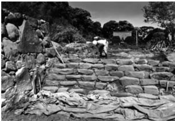
5 階段工 施工状況(三の段)
