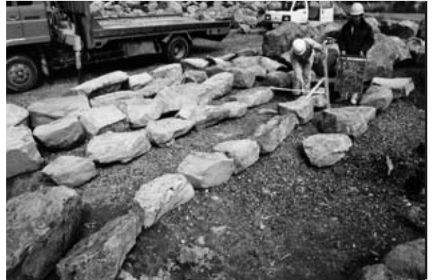
4 階段工 材料検収
