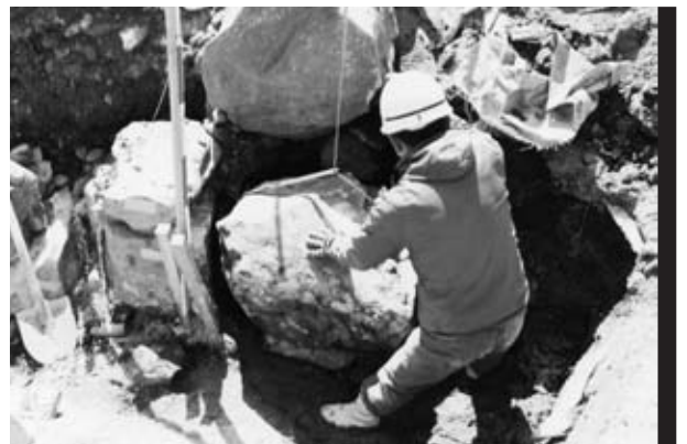
8 石垣③ 石据付
