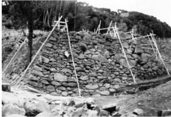
4 石垣② 着工前
