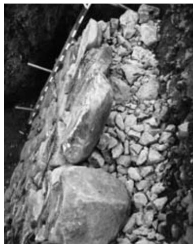
8 石積み工 (石垣①) 裏栗石投入状況
