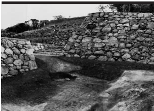
1 石垣②③⑫ 成工
