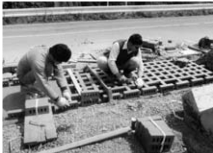
5 レンガ舗装 施工状況
