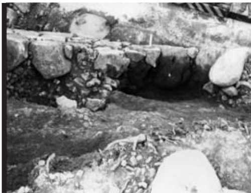
5 石垣⑫解体完了（南西から）
