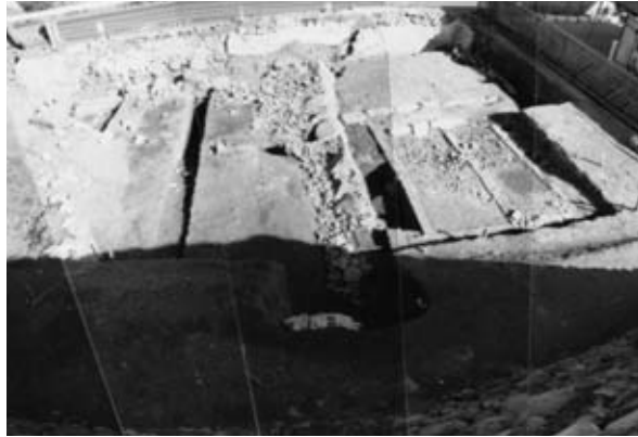
4 d地区 着工前
