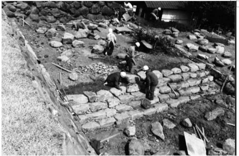
1 e 地区階段工施工状況
