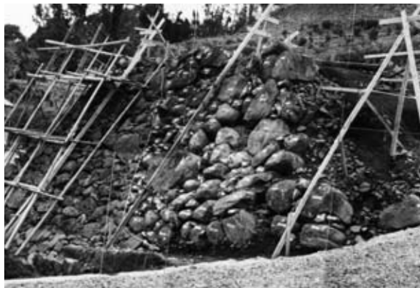
6 石垣②③ 着工前
