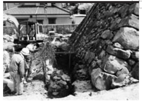
2 根石補強工 I (石垣②) 施工状況
