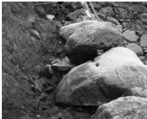
6 石垣⑫石垣背面の状況（南東から）
