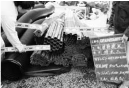
5 排水工 材料検収
