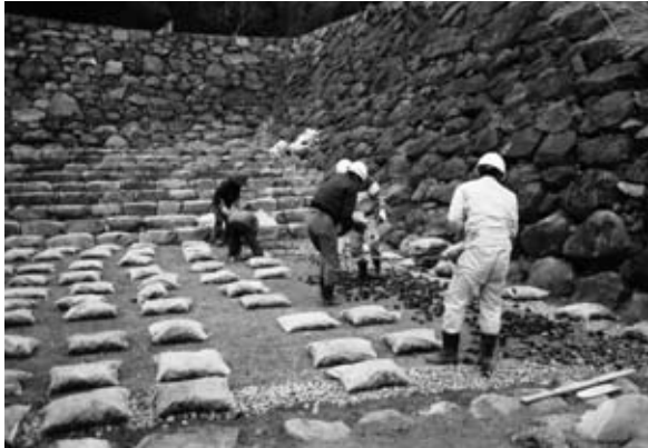
3 表層工(玉砂利工)施工状況
