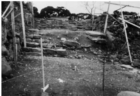
6 階段工 着工前 (石段 1~3)
