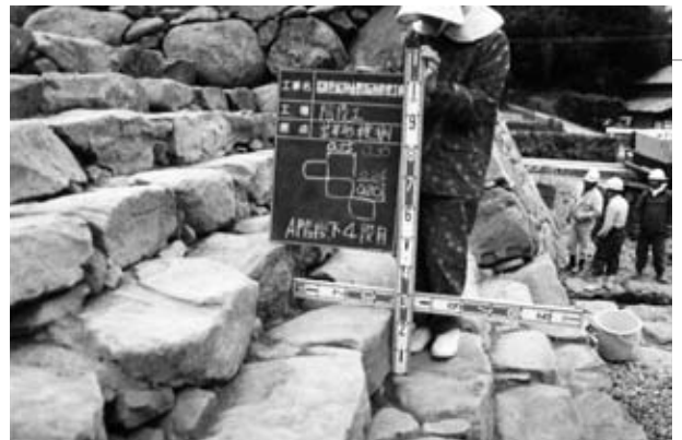
6 階段工(Aタイプ)出来形検測
