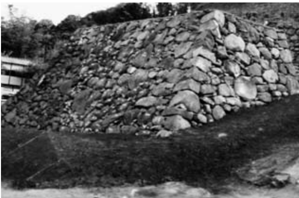
5 石垣②③ 成工
