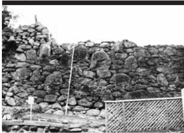
2 石垣① 着工前
