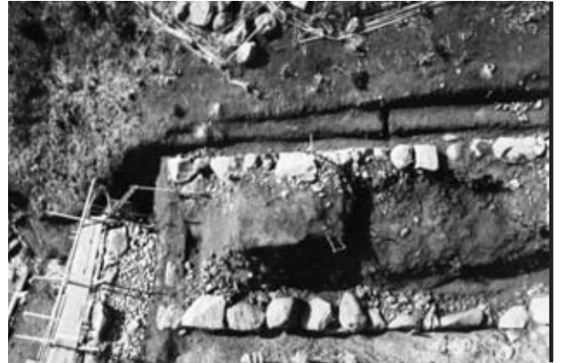
4 既設石積み撤去完了 (石垣⑥)
