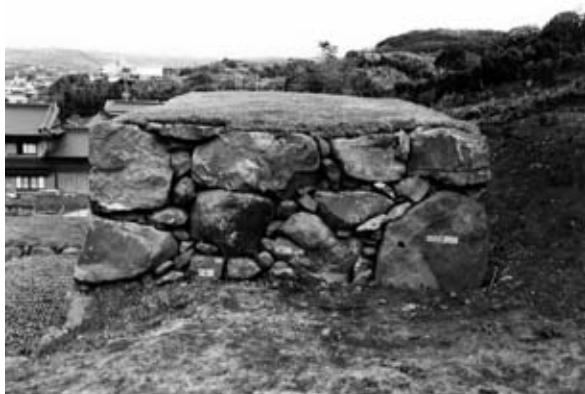
5 石垣⑦ 成工
