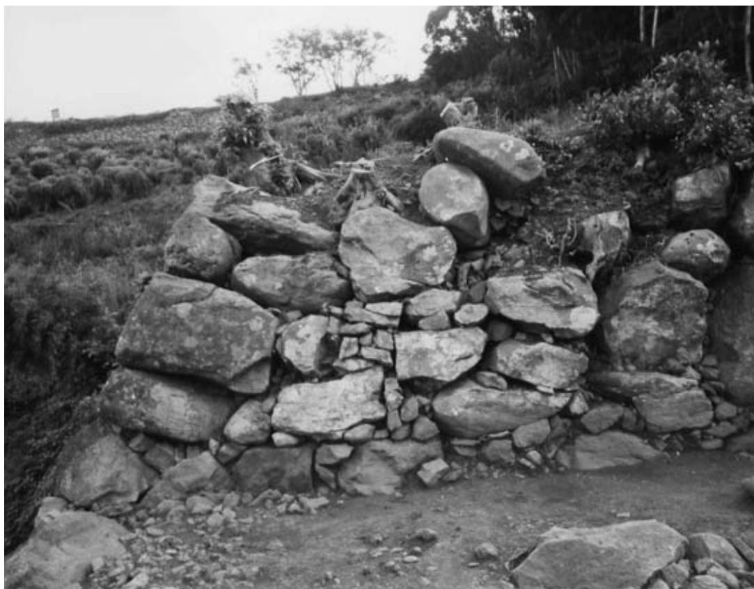
2 山里口石垣⑥石垣現状（北東から）
