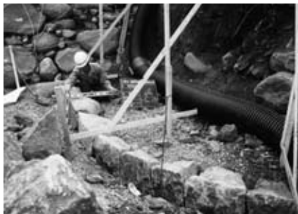
7 野面石積み及び縦排水路 (石垣⑩西端)
