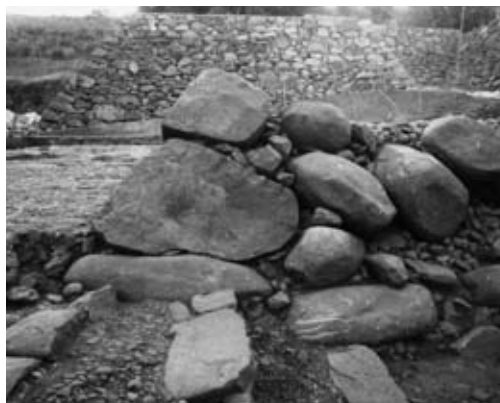
8 石垣⑯角 (東から)
