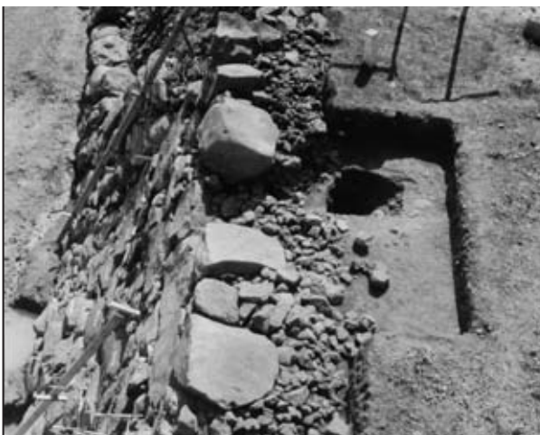
7 石垣⑫天端 (北から)
