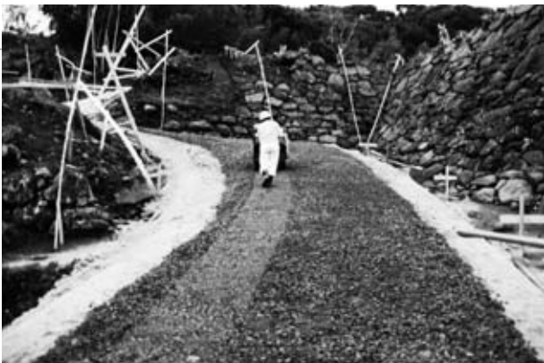
5 仮設道路 クラッシャーラン転圧状況
