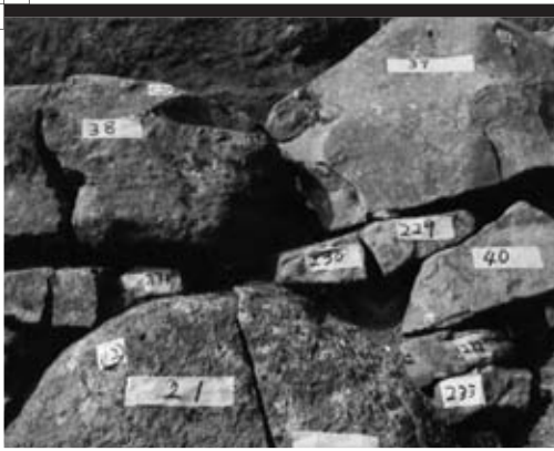
1 石垣⑫破損状況（北東から）
