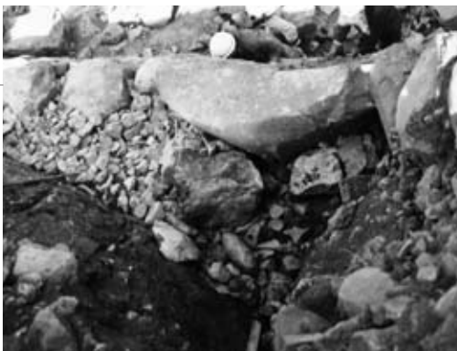
5 裏込め工（石垣② No.500付近）
