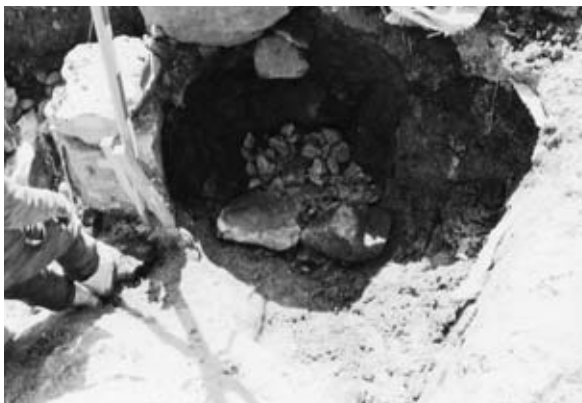
7 石垣③ 根固め完了
