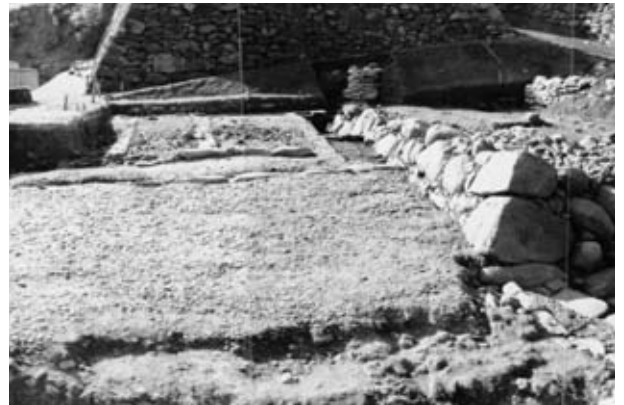
4 石垣⑩・五の段 着工前
