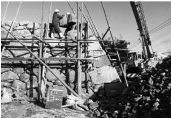
5 石積工 (石垣⑰天端より0.2m下)
