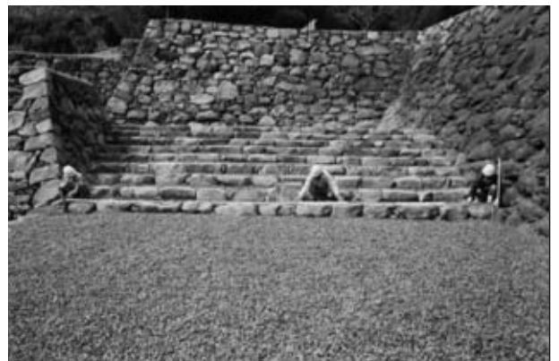
8 階段工(Bタイプ)出来形検測
