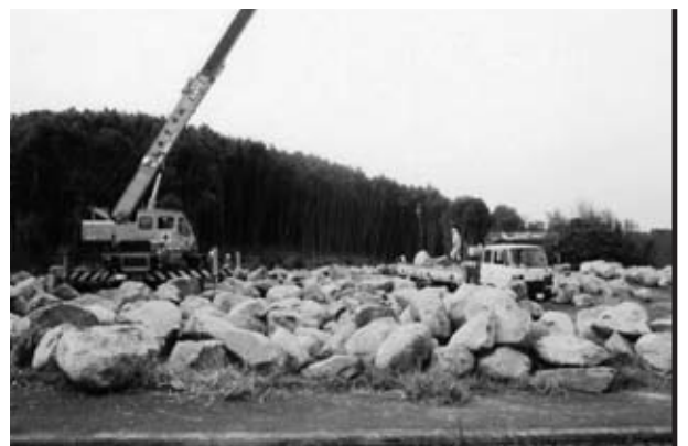
8 積石置場より石搬出状況
