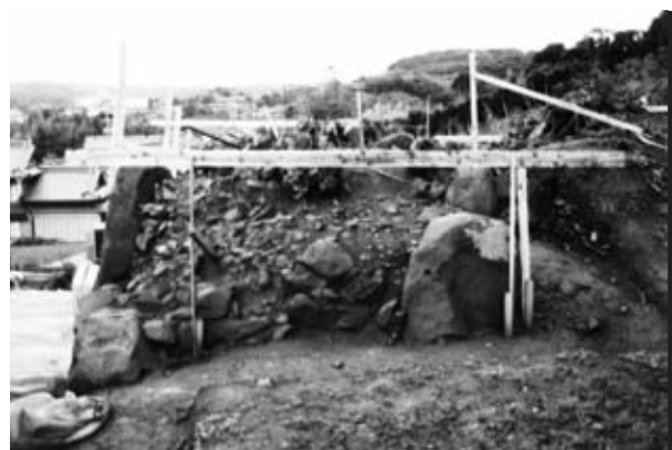
6 石垣⑦ 着工前
