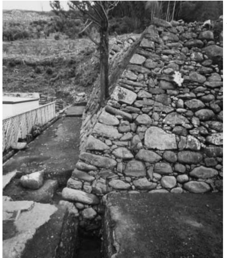
2 山里口石垣②角部分（北東から）
