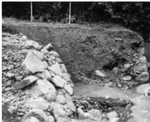
5 石垣⑱裏込め状況 (南東から)
