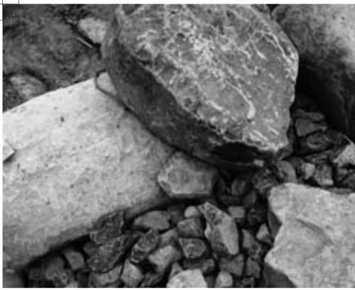
1 介石施工状況（石垣⑬）
