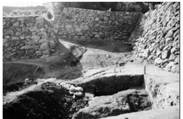
8 e地区 着工前
