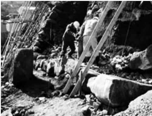
3 裏込め工（石垣② 裏込め石転圧状況）
