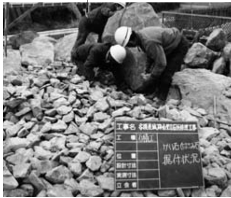
2 介石据付状況（石垣⑬）
