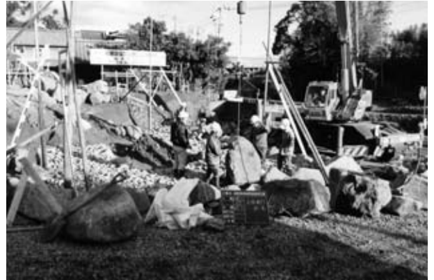
4 石積工 (石垣⑰天端より2.2m下)
