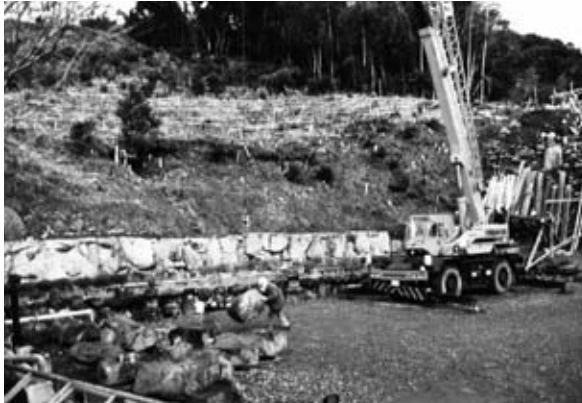
3 撤去石積 仮置状況
