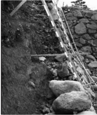
3 石垣⑫解体完了裏込め状況（南東から）
