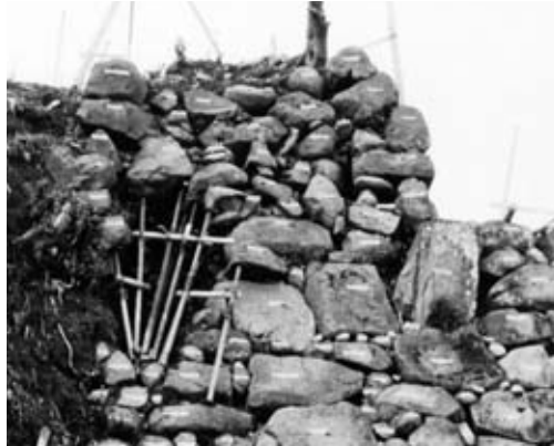
3 石垣①修理前（南から）
