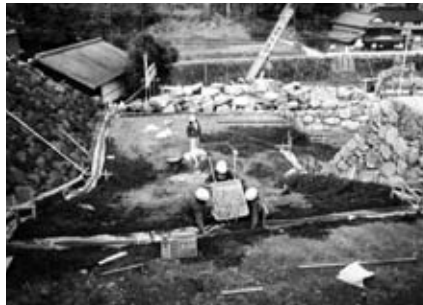
6 排水工 施工状況
