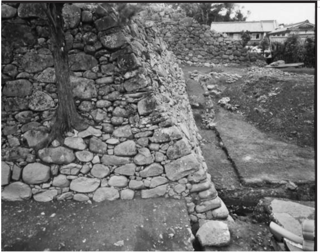
1 山里口石垣①角部分（南東から）
