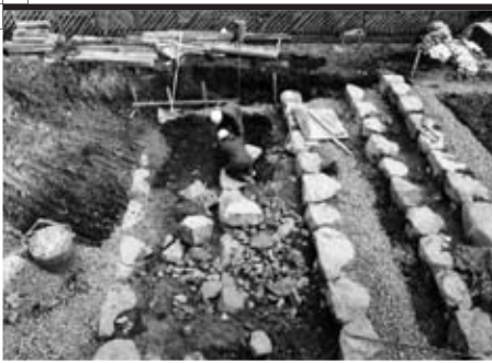
1 階段工 (Cタイプ) 施工状況
