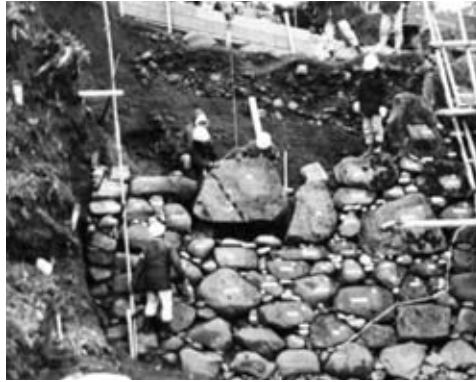
4 石積み工 (石垣①石積み状況)
