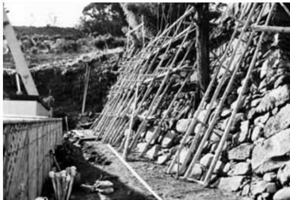
6 足場工 (石垣①)
