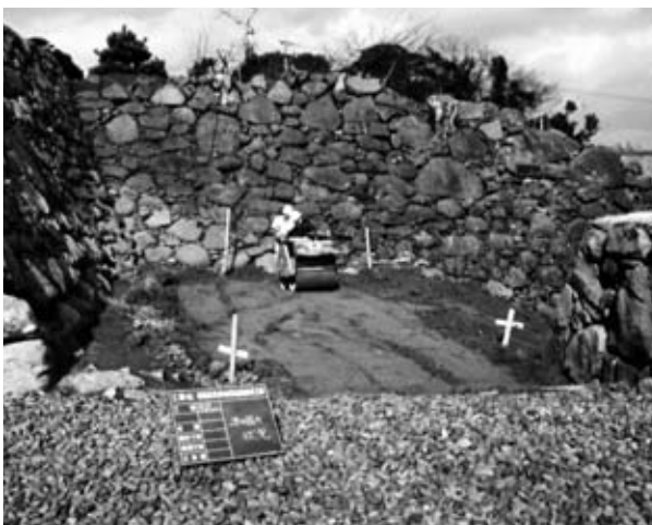
7 盛土転圧状況
