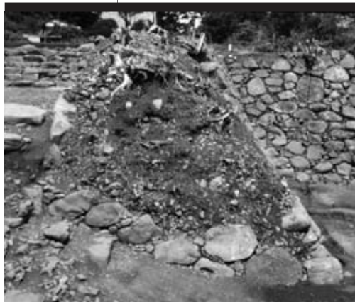
2 石垣⑪ (南東から)
