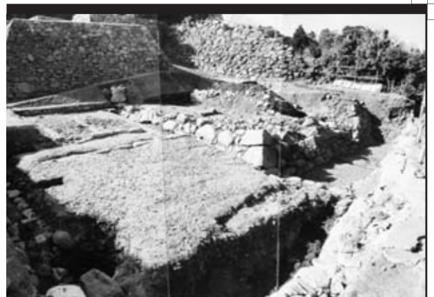
2 石垣⑩⑪ 着工前
