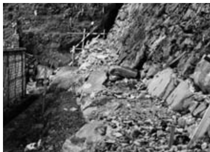
10 根石補強工II (石垣①)
