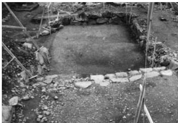
8 階段工 着工前 (石段 1~2)
