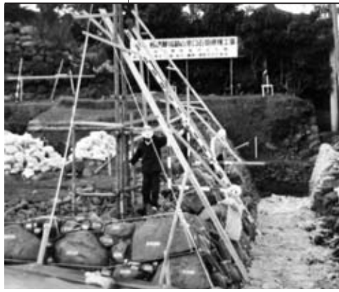
2 丁張設置状況 (石垣⑩・⑪)
