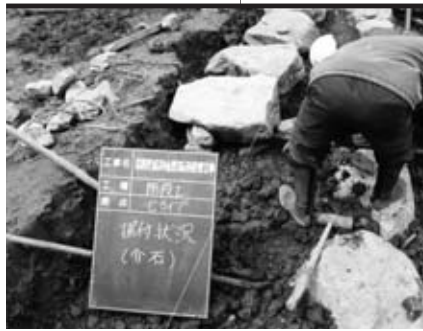
2 階段工 (Cタイプ) 介石据付
