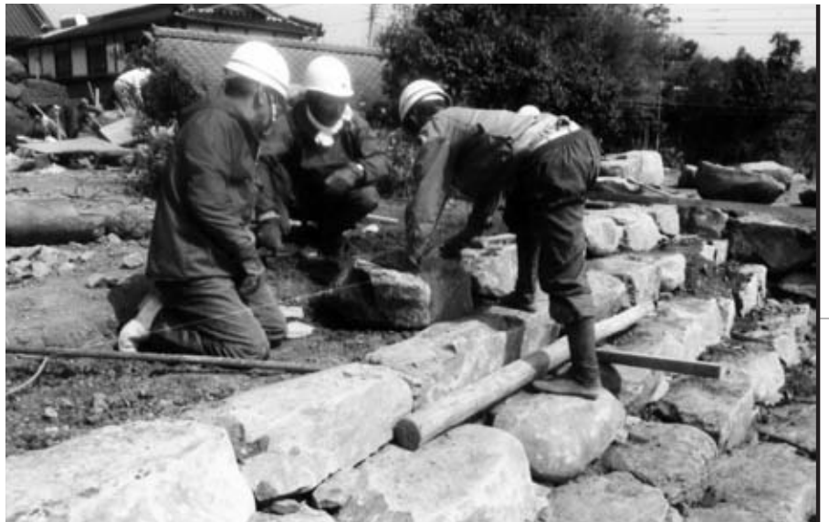
2 e 地区階段工施工状況
