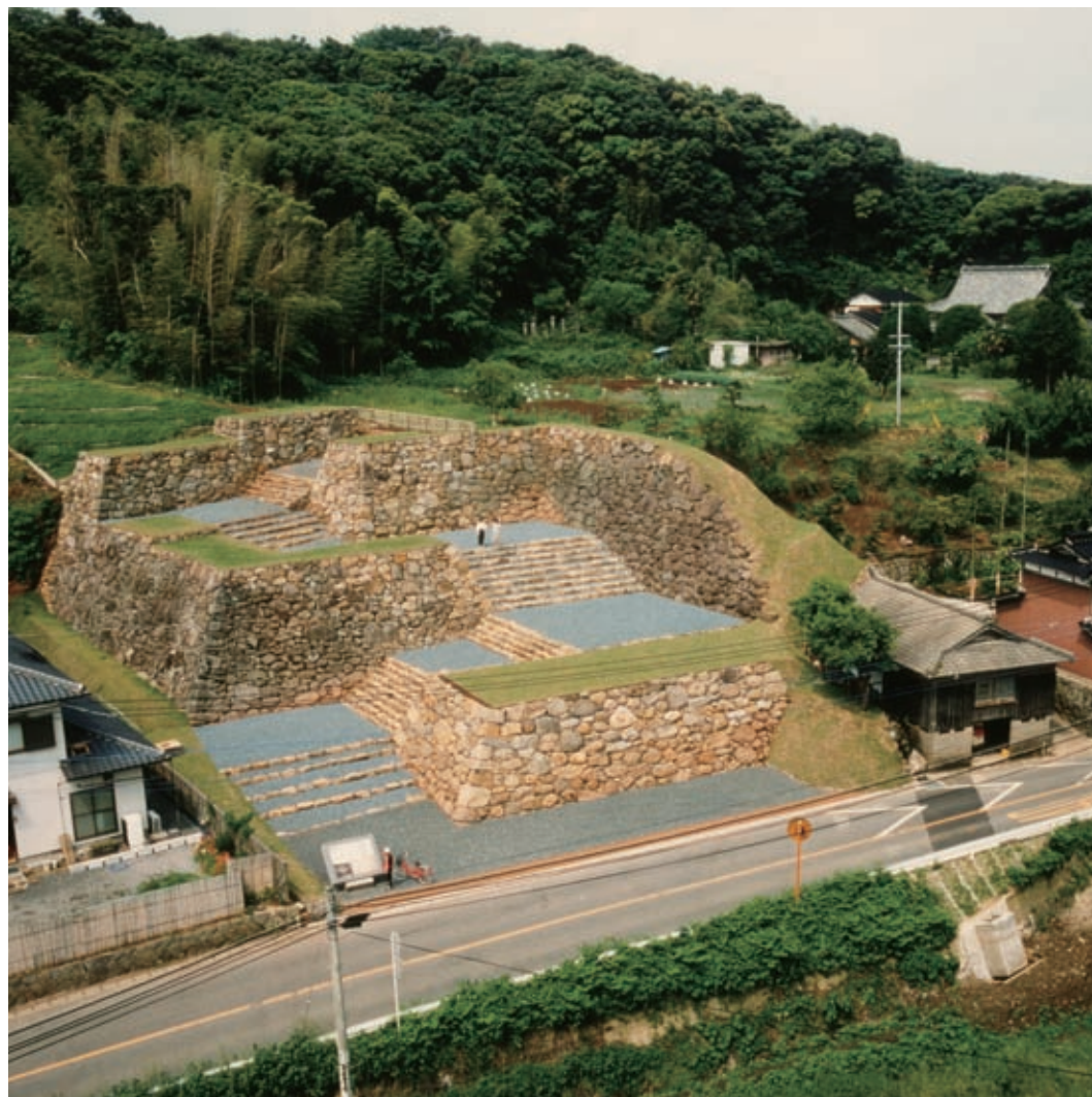
1 名護屋城跡山里口石垣修理完成写真（東から）
