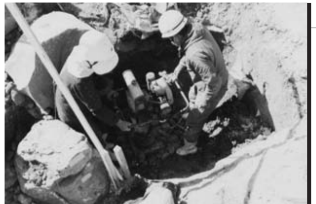
6 石垣③ 根固め施工状況
