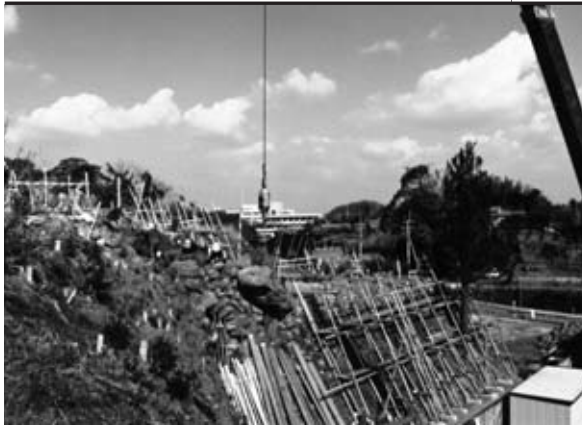
1 石積撤去状況 (石垣①)
