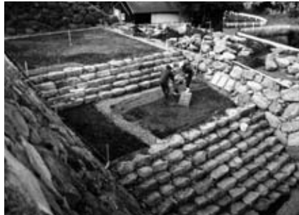
4 盛土転圧状況 (d 地区)
