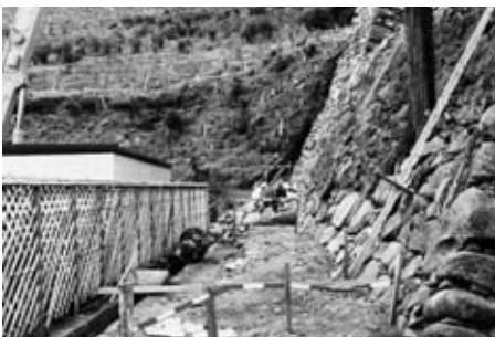
9 根石補強工II 施工状況
