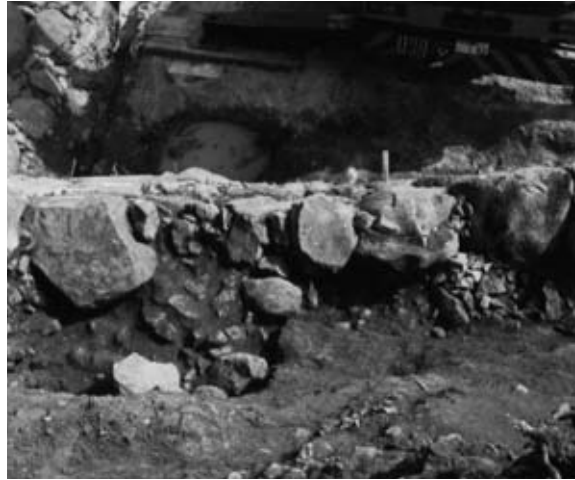
4 石垣⑫解体完了（南西から）
