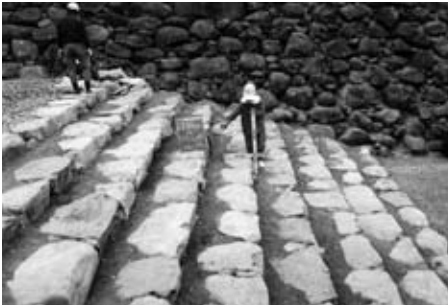
3 階段工 (Bタイプ) 5段目検測状況
