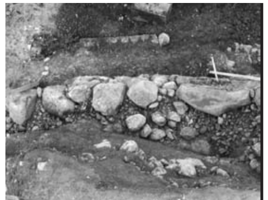
8 石垣②No.500付近裏栗状況 (南西から)
