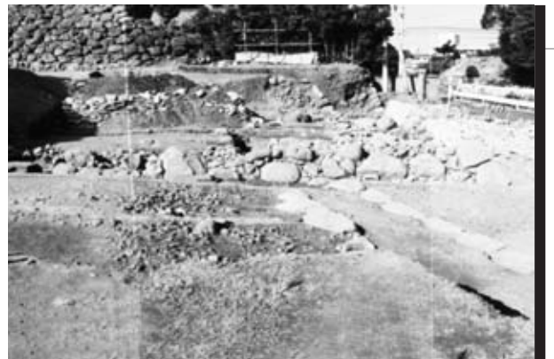
6 石垣⑰ 着工前
