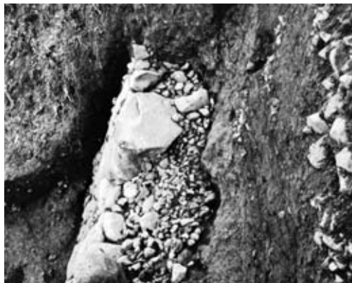
5 石垣①解体完了（南東から）
