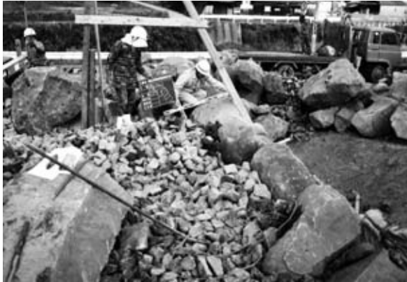
3 新規石材検測 (右側⑰天端より2.2m下)
