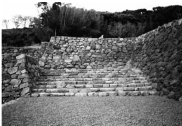
7 e地区 新規石段 成工
