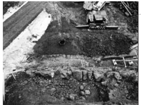
6 石垣②解体調査 天端付近 (南西から)
