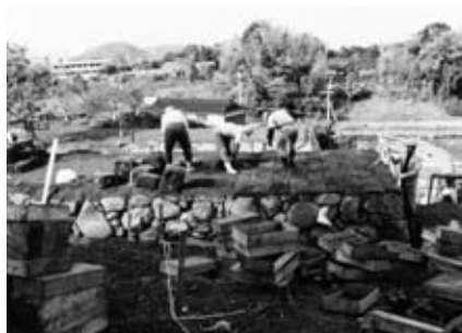
8 張芝工 (m 地区) 施工状況
