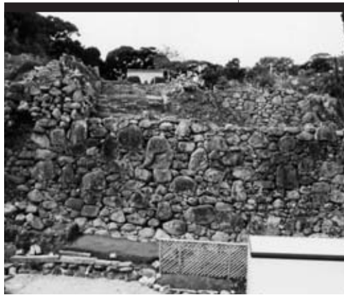
1 石垣①修理前（南東から）
