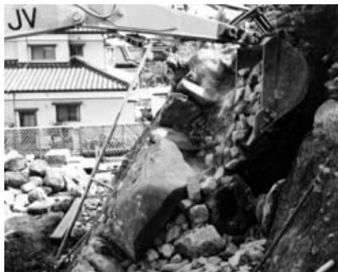
6 裏込め工（石垣② 裏込め石投入状況）
