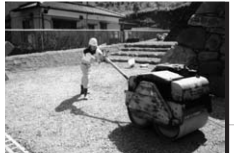
6 表層工 転圧状況 (a~b地区)
