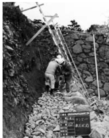
8 裏込め工（石垣⑫ 転圧状況）
