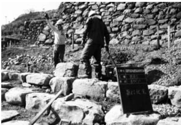
7 階段工(Bタイプ)施工状況
