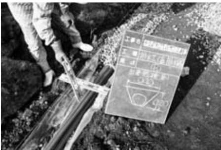
7 排水工 (盲排水路)
