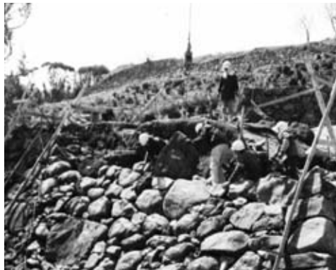
6 石積み状況 (石垣②)
