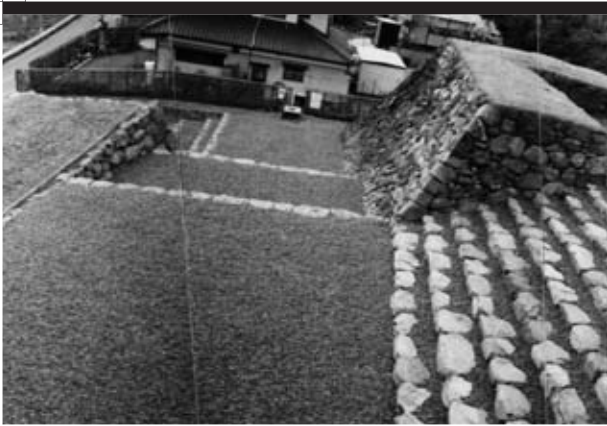
1 d・e地区 新規石段 成工
