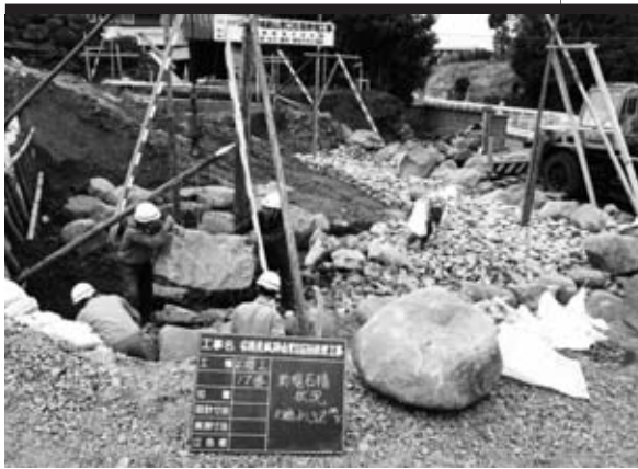
1 石積工 (石垣⑰天端より3.2m下)
