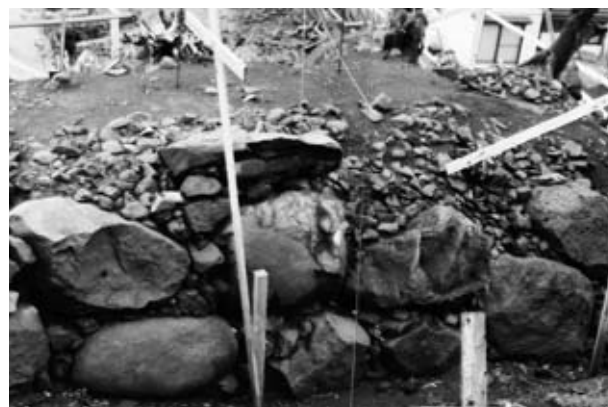
8 石垣⑧ 着工前
