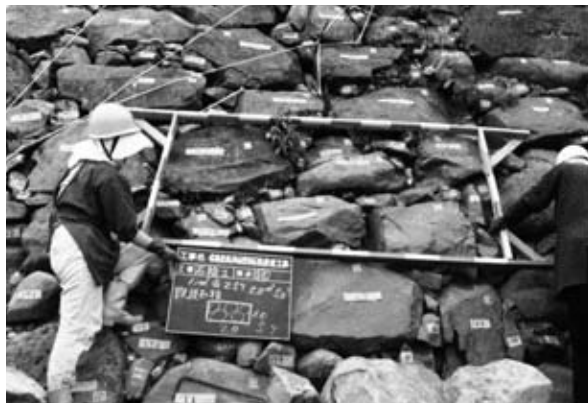
6 既設石積（石垣⑫）m 2 当たり個数検収
