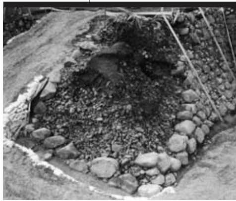
2 石垣⑫裏込め状況（東から）
