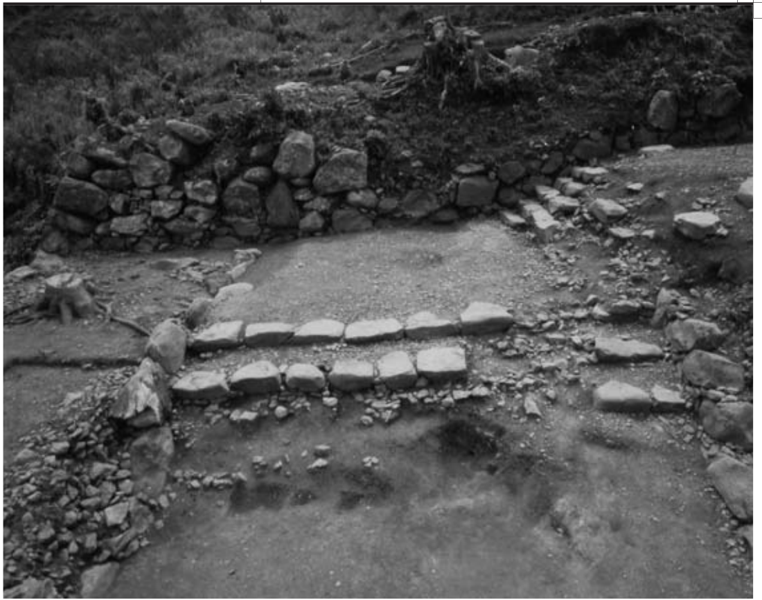
1 山里口一の段（北東から）
