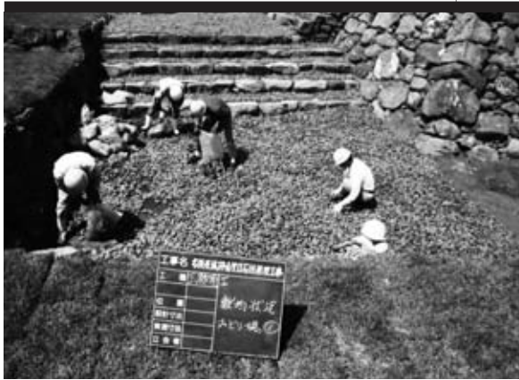
1 玉砂利工 玉砂利敷き均し
