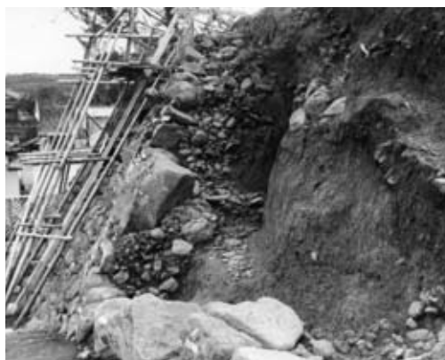
7 石垣②石垣背面（北東から）
