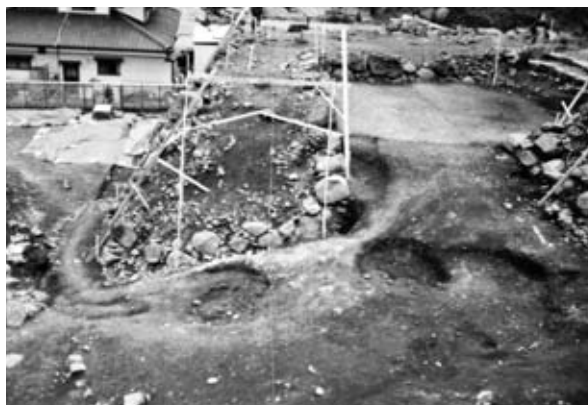
8 石垣③⑤ 着工前
