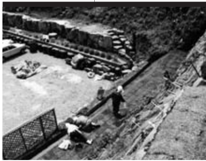
1 根石補強工 芝張状況
