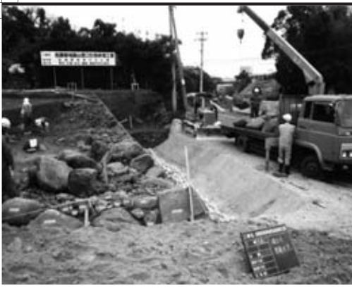
1 石材運搬・積み下し状況
