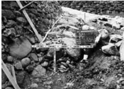
3 根石補強工 I (石垣②)
