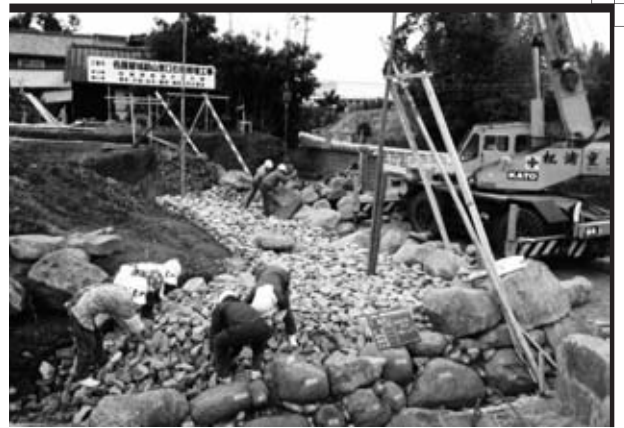
2 石積施工状況 (石垣⑯天端より3.2m下)
