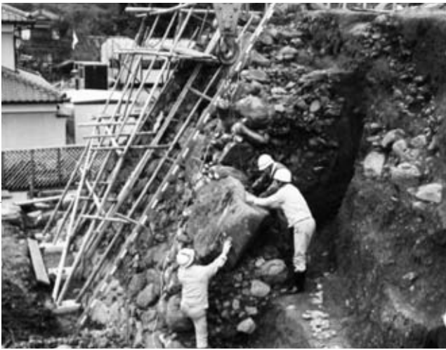
3 石垣②石垣解体状況（北から）
