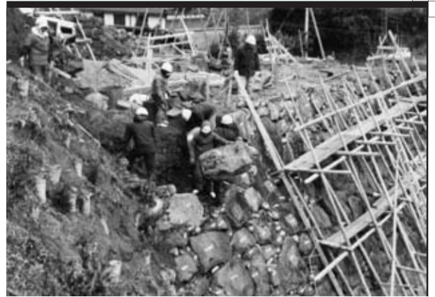
2 石積撤去状況 (石垣①)
